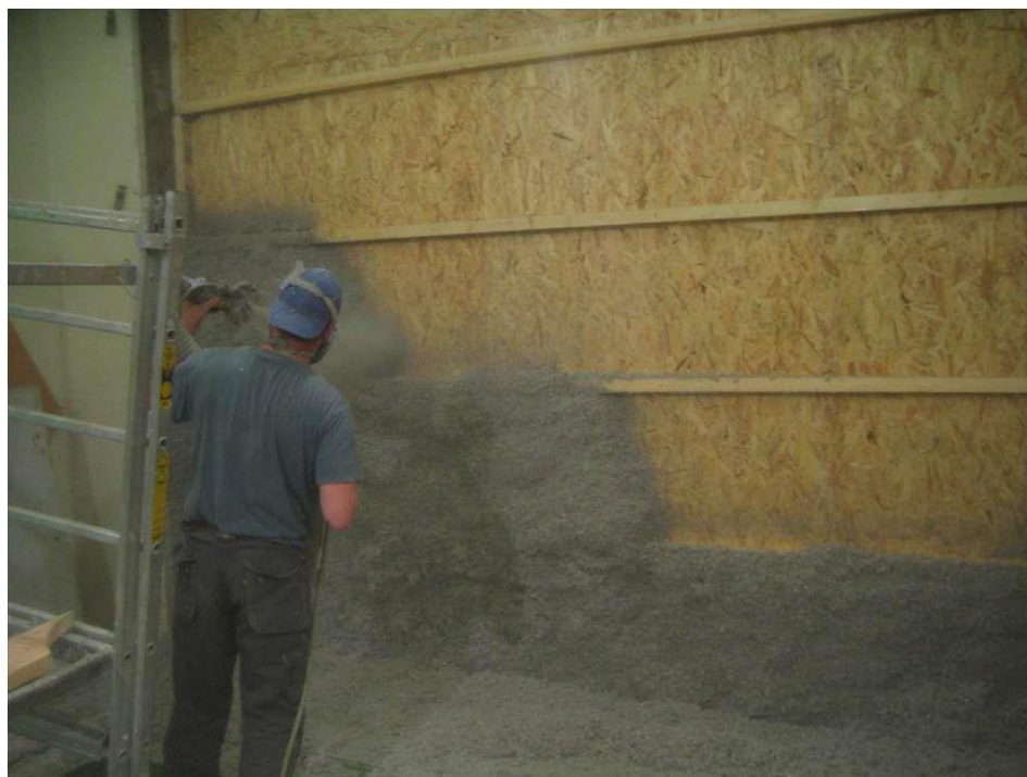
Ściana zewnętrzna Termex Zero (natrysk izolacji od strony wewnętrznej)
